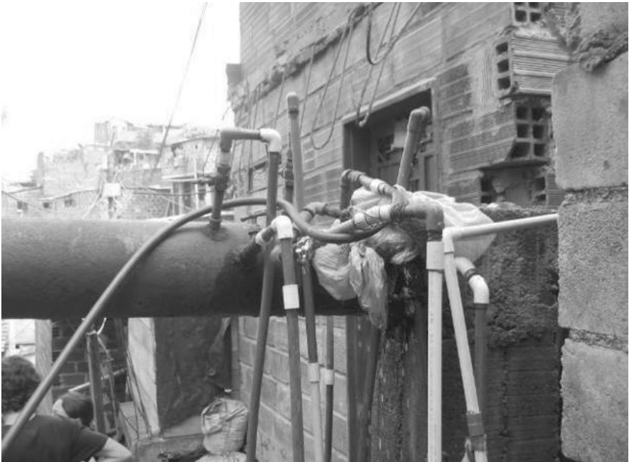
Figura 30. Perforaciones indiscriminadas a la red de agua de EPM.
