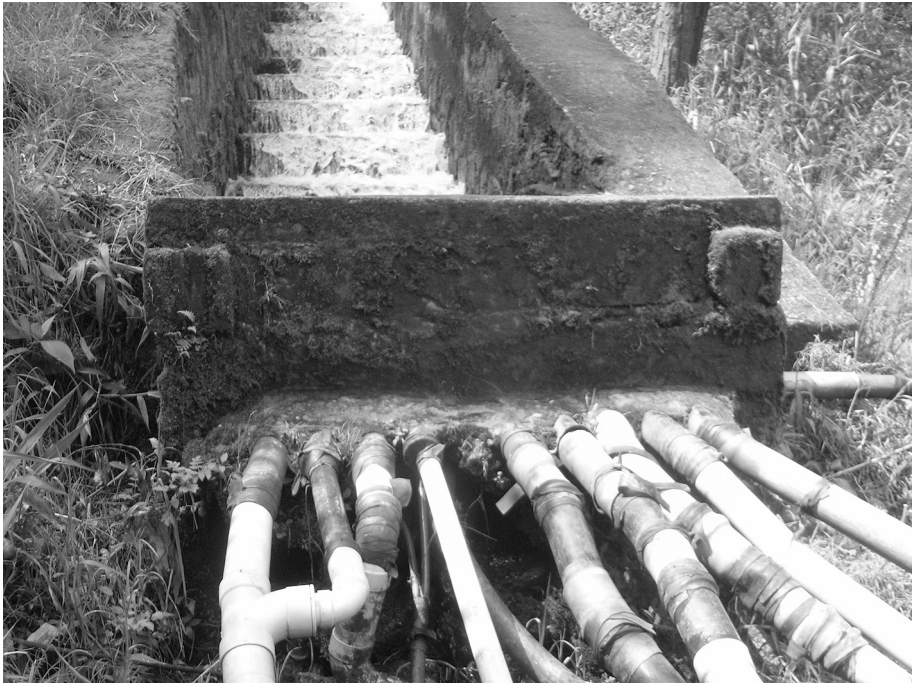
Figura 29. Infraestructura alternativa construida por habitantes de Bello Oriente para captar el agua cruda que se desborda de un tanque de EPM.
