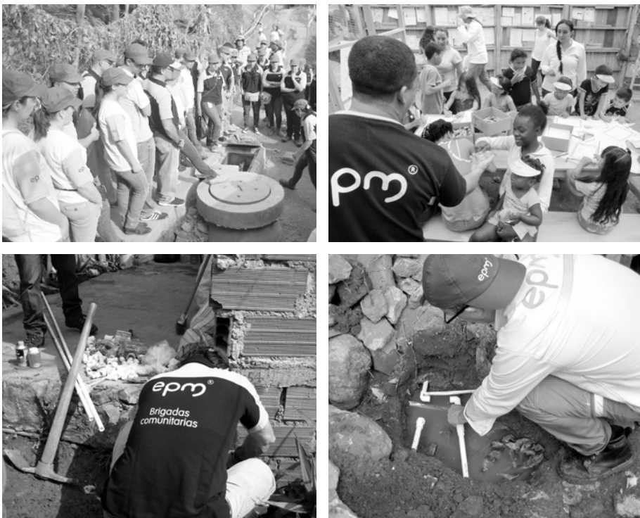
Figura 22. Actividades desarrolladas durante las Brigadas Comunitarias de Mitigación del Riesgo: Instalación de un medidor comunitario (izquierda arriba), ejecución de un programa recreativo (derecha arriba) y reemplazo de tuberías (abajo izquierda y derecha).
