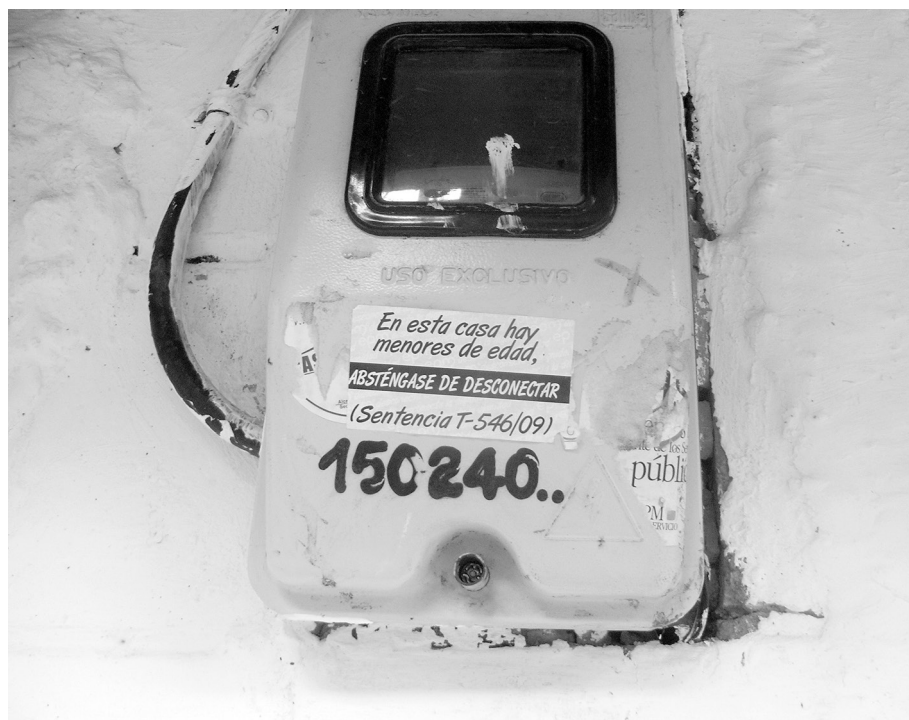
Figura 25. Campaña de concientización en un medidor de energía ubicado en la fachada de una vivienda de bajos ingresos para evitar la desconexión por no pago.
