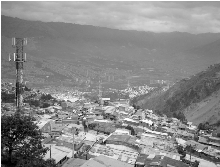
Figura 28. El barrio Santo Domingo Savio en la periferia de Medellín se clasifica como “zona de alto riesgo”.
