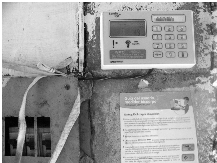
Figura 24. Medidor de energía prepago instalado en una vivienda del barrio El Limonar.
